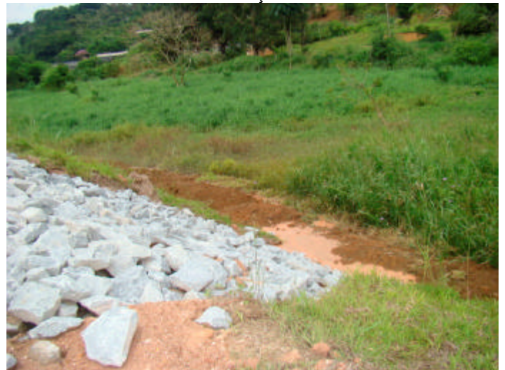
Foto 8 – Detalhe do sedimento de granulometria mais fina à jusante da estrutura em rachão.
