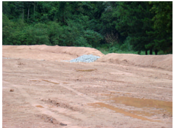
Foto 2 – Detalhe do dispositivo de drenagem provisório composto por diques de retenção de águas pluviais e estruturas em rachão voltadas à retenção de sedimento e ao disciplinamento do escoamento.
